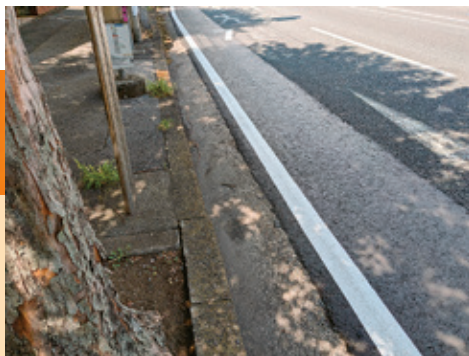
国際理工専門学校前舗装改修
