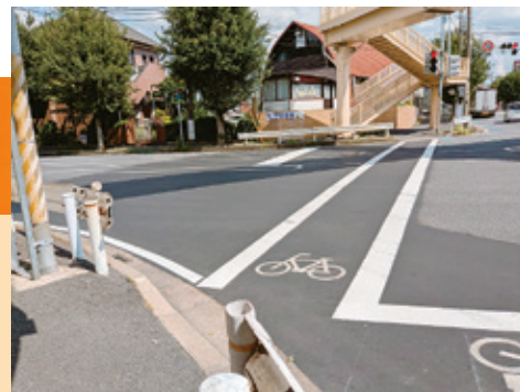
穴川十字路舗装改修
